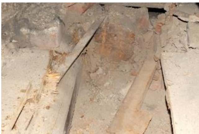
5) Sonda S18 - poškození ST činností dřevokazných hub (místo odběru VZ 2)
