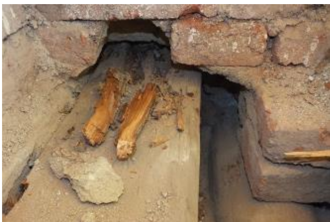
1) Sonda S17 - poškození ST činností dřevokazných hub (místo odběru VZ 1)
