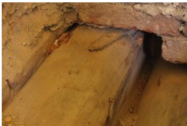
2) Sonda S18 - poškození ST činností dřevokazných hub (místo odběru VZ 2)
